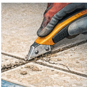
Remover completamente o rejunte antigo
