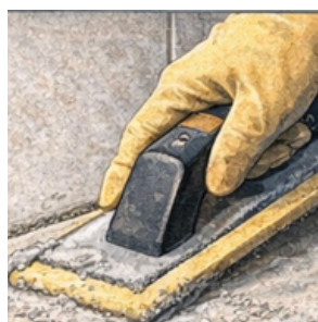
Aplicar o novo rejunte
