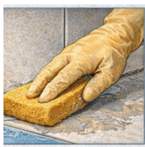
Limpar completamente as juntas
